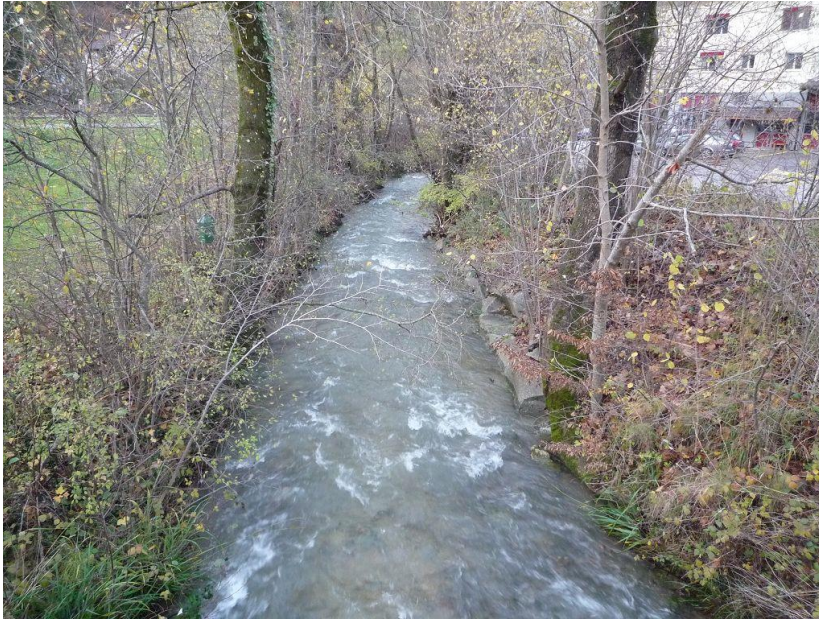
Abbildung 7 Die Vordere Frenke in Höhe Haltestelle Hirschlang: die Ufer sind mit Blocksteinen gesichert und mit einem Galeriewald bestanden
