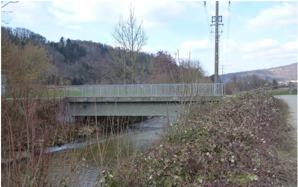
Bubendorf: Zufahrtsbrücke über die Vordere Frenke mit untergezo- genem AIB-Kanal zur ARA Frenke 3, Blick bachaufwärts
