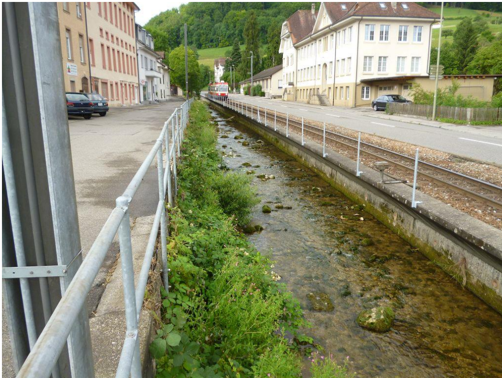
Bahn-km 11.100: Frenke mit ca. 4 m Sohlbreite, Blick gegen die Fließrichtung
