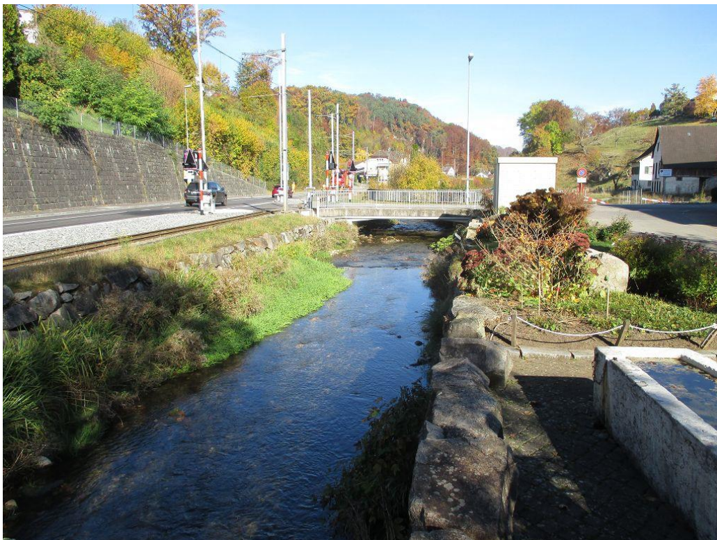
Niederdorf, Bahn-km 10.630: Mühlebrücke (wird erhalten), Blick in Fließrichtung
