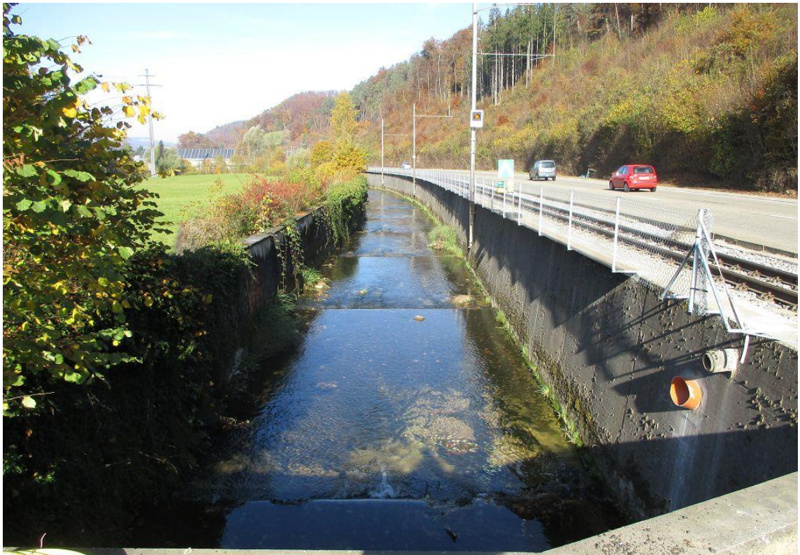
Hölstein, Bahn-km 7.120: Frenke mit beidseitigen Ufermauern und Sohlschwellen, vorgesehen ist die Verlegung der Frenke um ca. 20 m nach Westen, Blick bachabwärts
