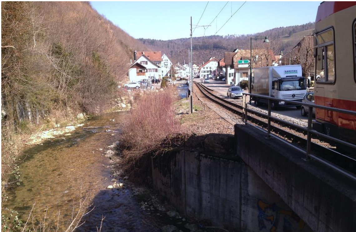
Hölstein, Bahn-km 8.350: Blick von der Postbrücke bachabwärts
