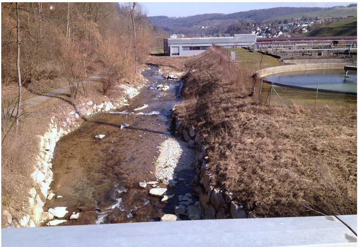
Niederdorf: Vordere Frenke, Höhe ARA, Blick bachabwärts
