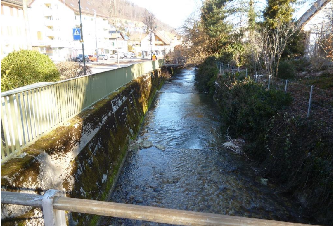
Oberdorf: Bahn-km 12.400, Vordere Frenke in Höhe Haltestelle Oberdorf, Blick bachabwärts
