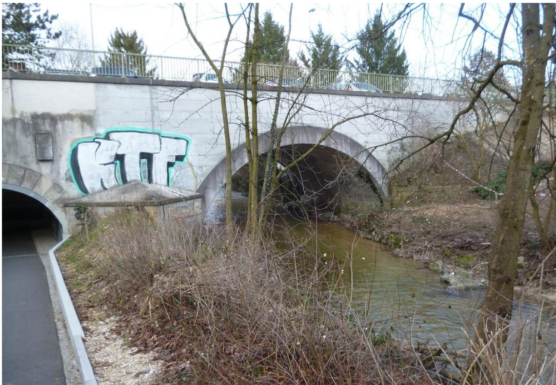
Liestal: Brücke Kasernenstrasse, Blick bachabwärts
