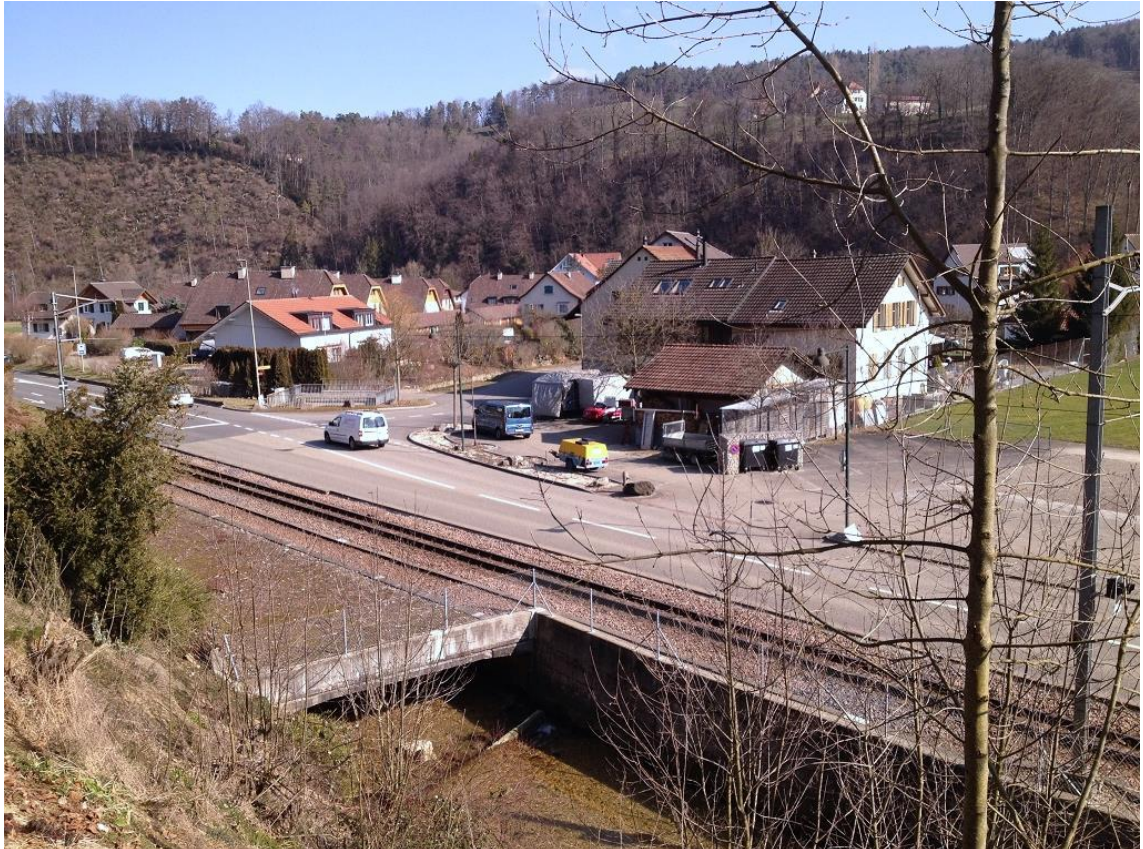
Hölstein, Bahn-km 7.820: Einlauf in die Eindolung Hölstein Nord
