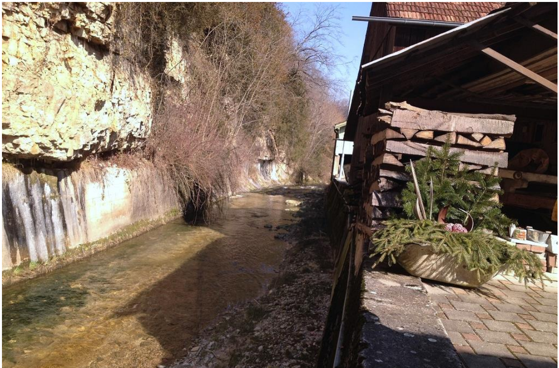
Hölstein, Bahn-km 8.080: unterhalb von Hauptstrasse Nr. 22 liegt die Frenkesohle auf dem Fels
