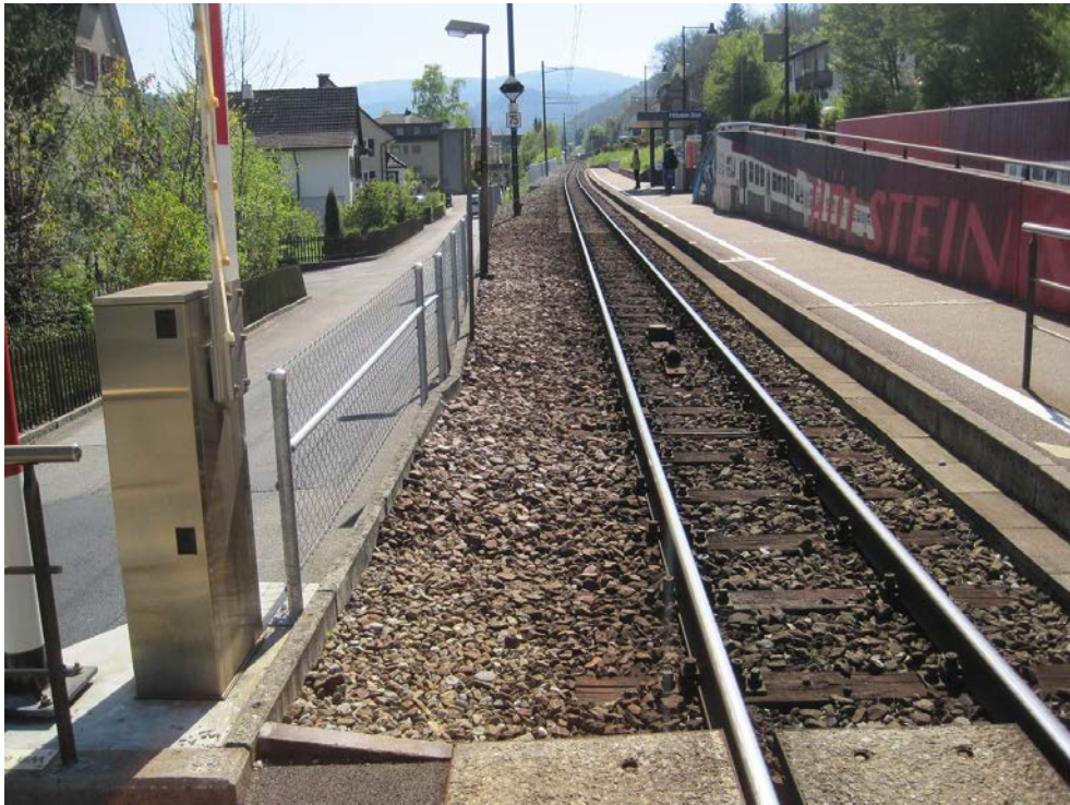
Bild 17: HST Hölstein Süd, best. BÜ, Blickrichtung Süden, km 8.520
