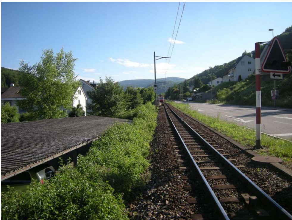
Bild 28: Bahntrasse Bereich BUe Dammstrasse, Blickrichtung Süden, km 8.983
