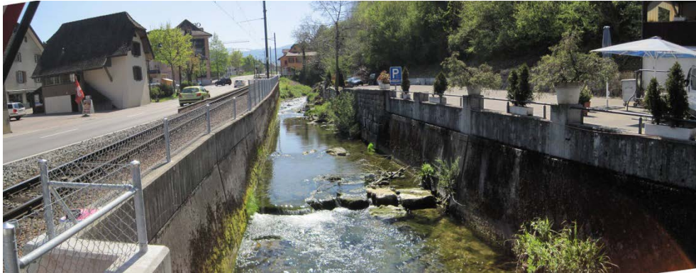
Bild 10: Bahnübergang Restaurant Linde, Blickrichtung Süden, km 8.223
