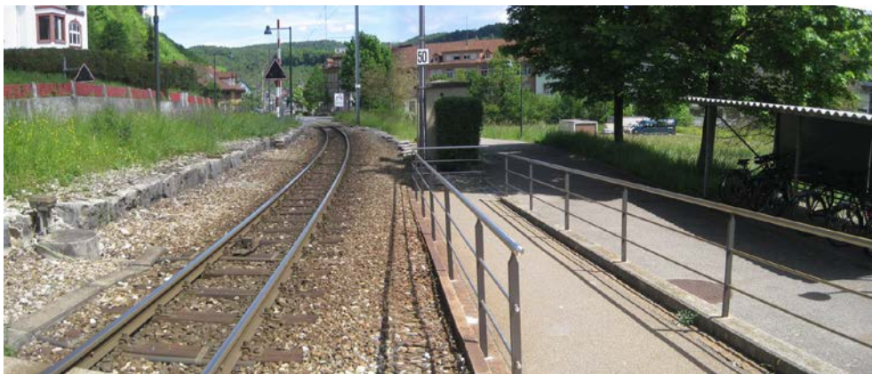
Bild 16: HST Hölstein Süd, Blickrichtung Norden km 8.478
