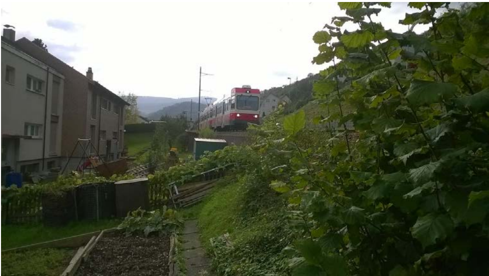
Bild 26: Böschung Dammstrasse Nr. 14, Blickrichtung Süden, km 8.905
