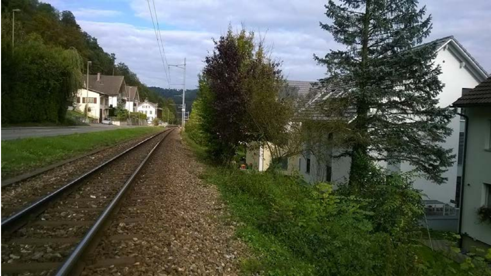
Bild 25: Bahntrasse Bereich Dammstrasse 14, Blickrichtung Norden, km 8.900
