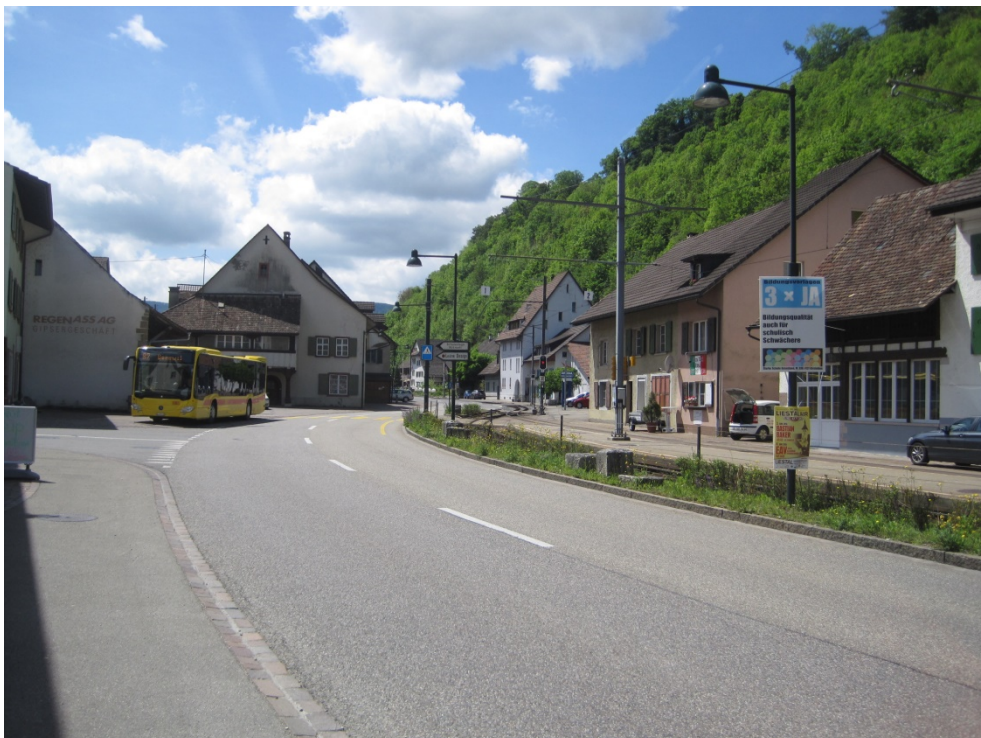
Bild 3: Hauptstrasse, Blickrichtung Süden, km 7.977
