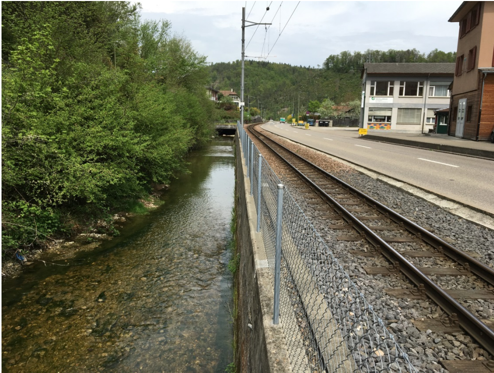
Bild 2: Hölstein Bachmauer, Blickrichtung Norden, km 7.900
