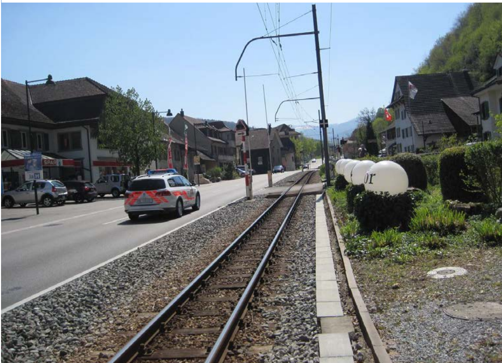
Bild 6: Hauptstrasse Blickrichtung Süden, km 8.145
