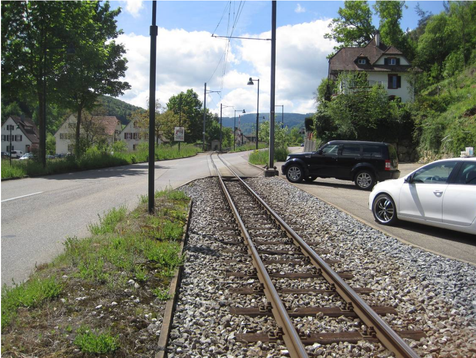
Bild 14: BUe Hauptstrasse Blickrichtung Süden, km 8.396
