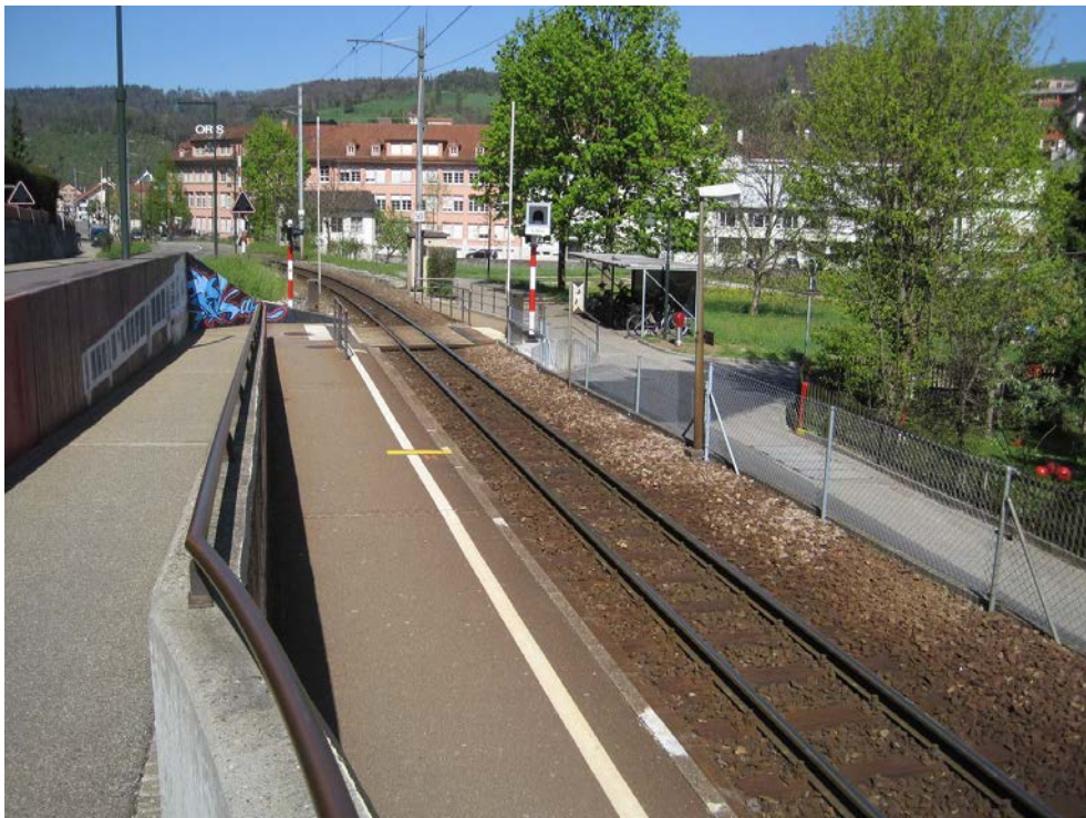
Bild 18: HST Hölstein Süd, best. Rampe, Blickrichtung Norden, km 8.472
