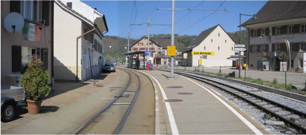
Bild 5: Haltestelle Hölstein, Blickrichtung Norden, km 8.009
