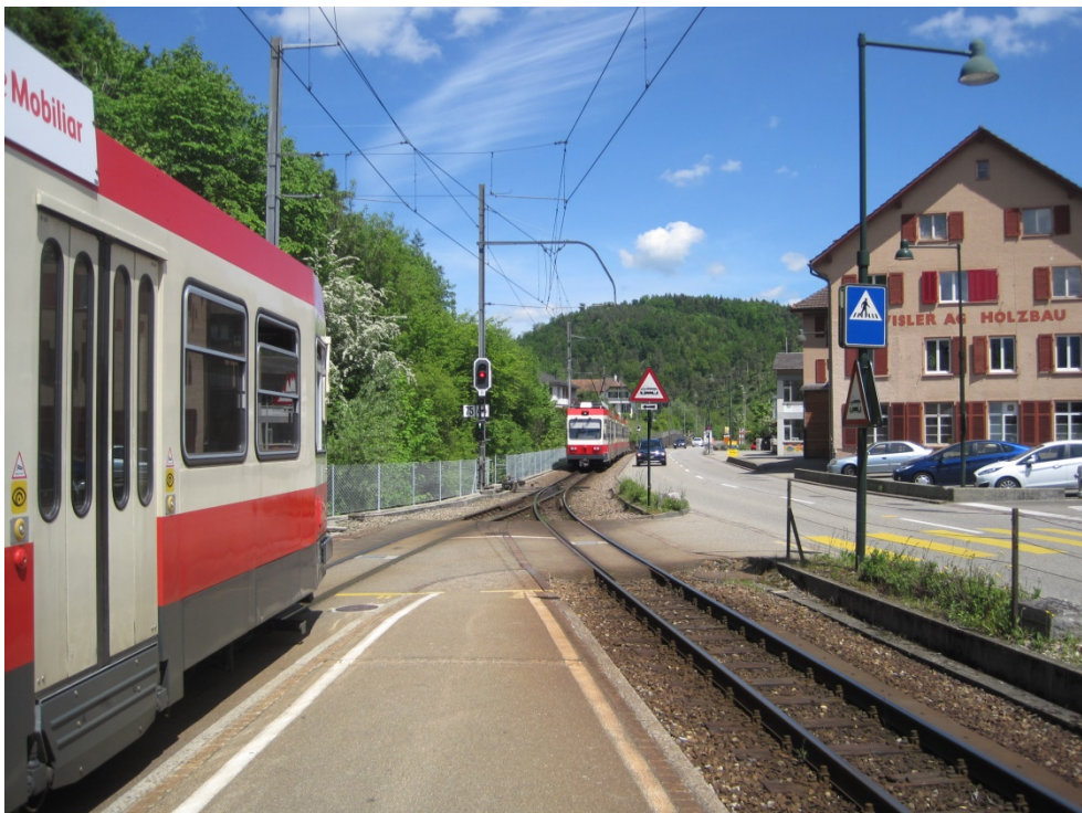
Bild 1: Haltestelle Hölstein, Blickrichtung Norden, km 7.909
