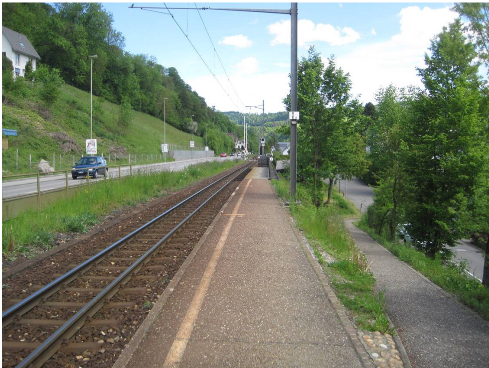
Bild 30: HST Weidbächli, Blickrichtung Norden, km 8.086
