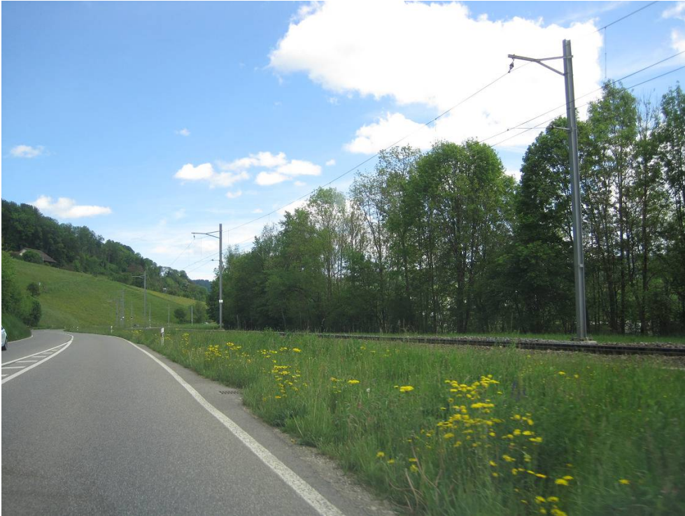
Bild 33: Bahntrasse entlang Hauptstrasse, Blickrichtung Norden, km 9.786
