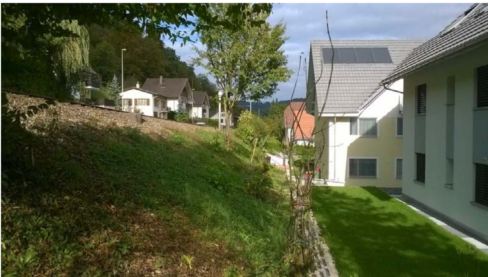
Bild 23: Böschung Dammstrasse Nr. 12b, Blickrichtung Norden, km 8.885
