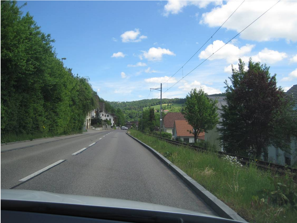
Bild 24: Hauptstrasse Nr. 64, Blickrichtung Norden, km 8.870
