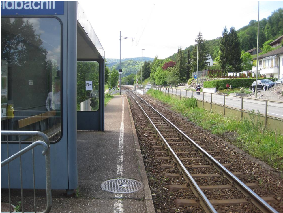
Bild 31: HST Weidbächli, Blickrichtung Süden, km 9.086
