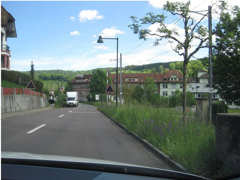
Bild 15: BUe Hauptstrasse Blickrichtung Norden, km 8.472
