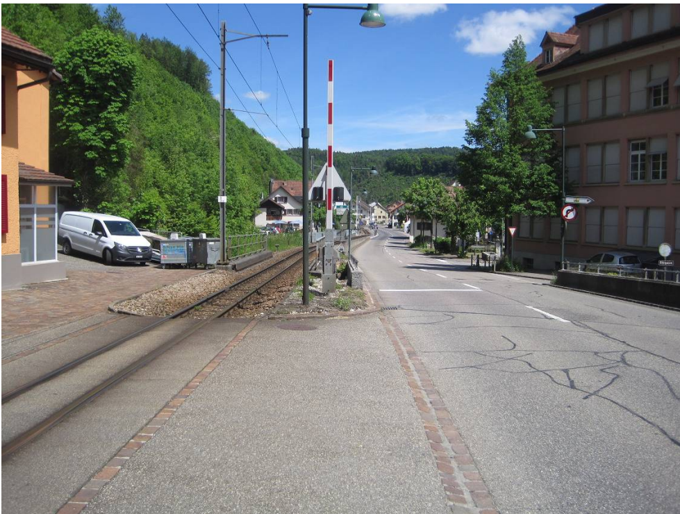
Bild 11: BUe 083 Garage, Blickrichtung Norden, km 8.380
