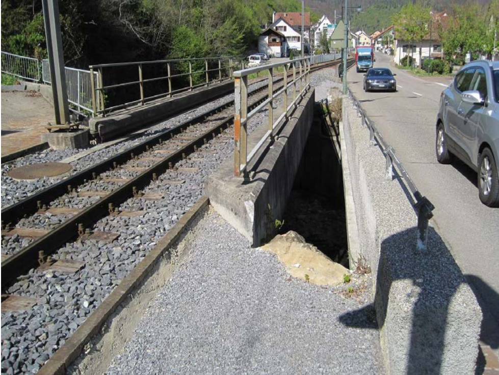
Bild 12: Frenkenbrücke, Blickrichtung Norden, km 8.361
