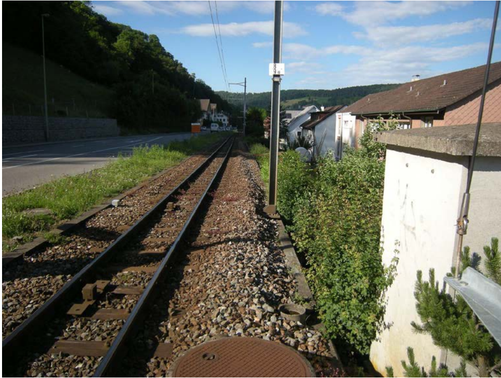
Bild 29: Bahntrasse Bereich Dammstrasse Nr. 20, Blickrichtung Norden, km 8.970
