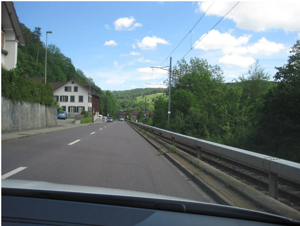
Bild 21: Hauptstrasse Nr. 54, Blickrichtung Norden, km 8.748
