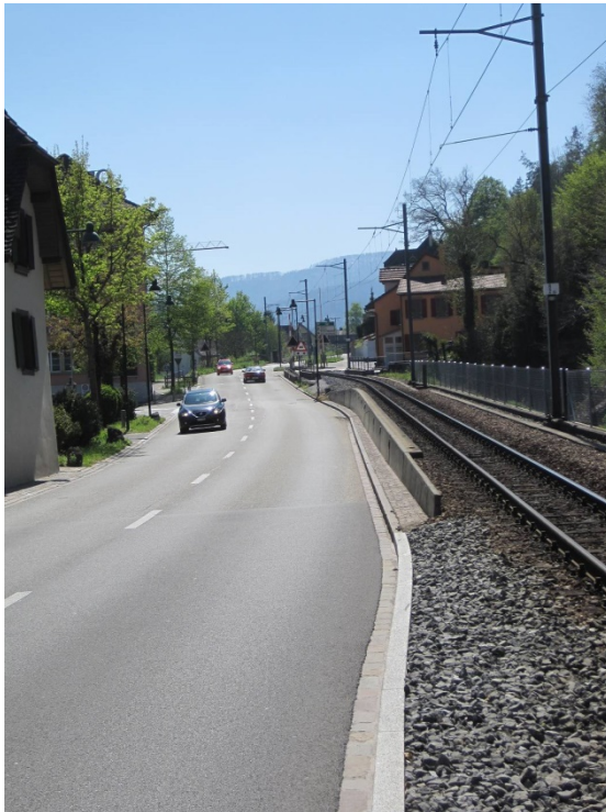
Abbildung 9: Hauptstrasse Blickrichtung Süden, km 8.244
