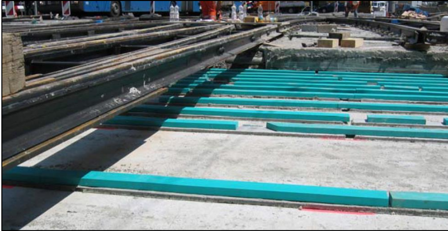
Abbildung 19: Leichtes Masse-Feder-System mit Streifenlager am Bahnhofplatz in Zürich [20]
