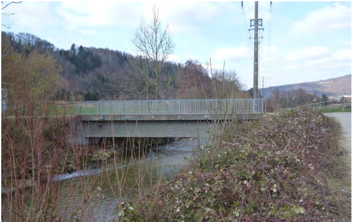
Bubendorf: Zufahrtsbrücke über die Vordere Frenke mit untergezoogenem AIB-Kanal zur ARA Frenke 3, Blick bachaufwärts
