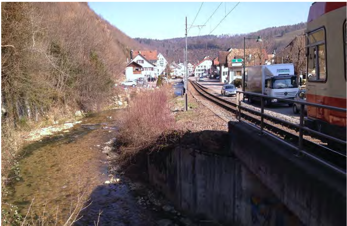
Hölstein, Bahn-km 8.350: Blick von der Postbrücke bachabwärts
