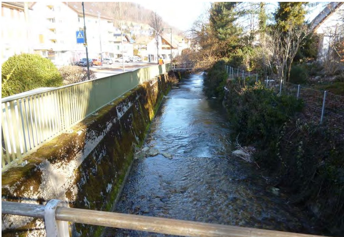
Oberdorf: Bahn-km 12.400, Vordere Frenke in Höhe Haltestelle Oberdorf, Blick bachabwärts
