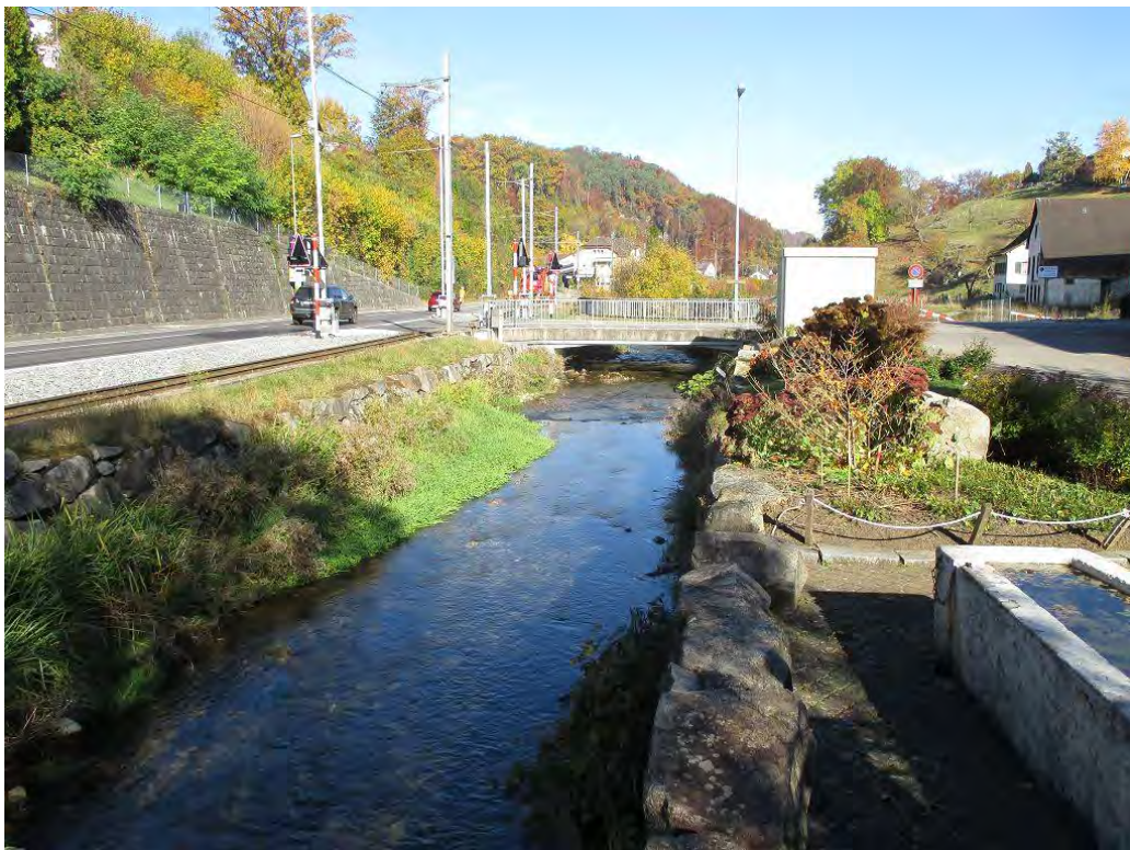
Niederdorf, Bahn-km 10.630: Mühlebrücke (wird erhalten), Blick in Fliessrichtung
