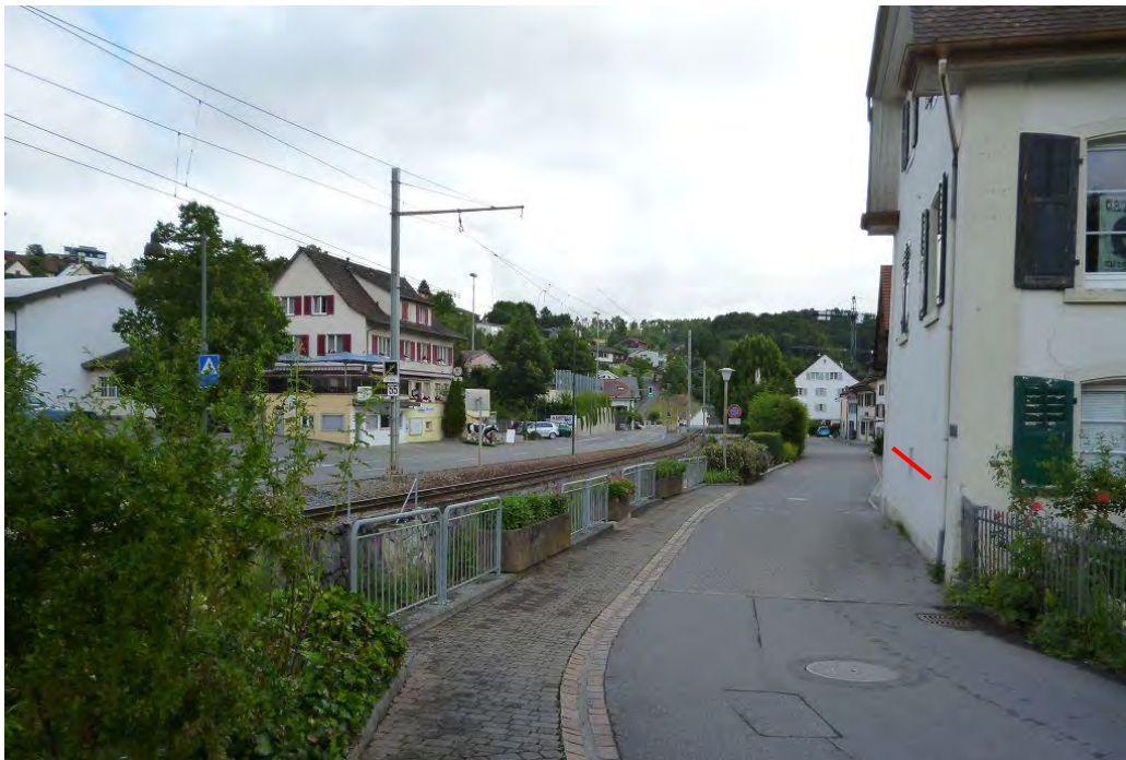
Bahn-km 10.900: Engstelle Dorfstraße Nr. 40. An der Hauswand ist eine Hochwasser- marke vom Hochwasser 16.07.1830 erkennbar und rot gekennzeichnet (Abfluss 60 - 100 m 3 /s gem. Hydrologie der Scherrer AG). Blick in Fließrichtung
