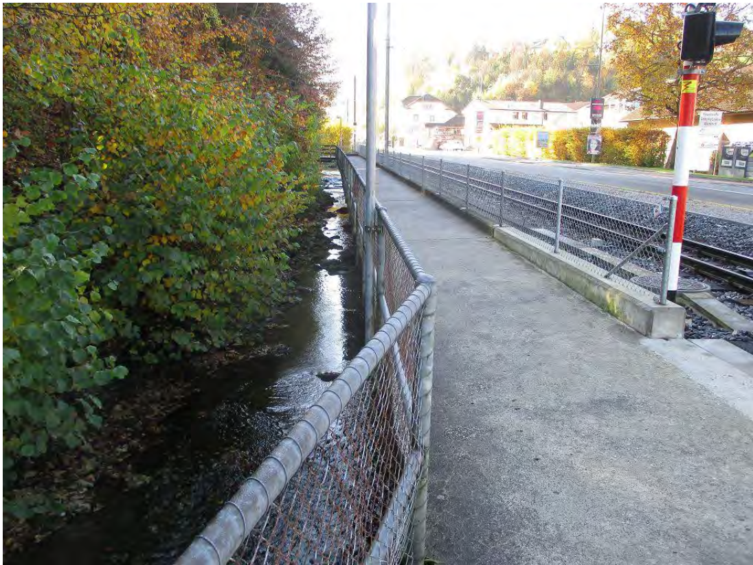
Niederdorf, Bahn-km 10.340: überkragender Wanderweg an Felsnase Steinler (Losgrenze 5 / 6), Blick gegen die Fließrichtung
