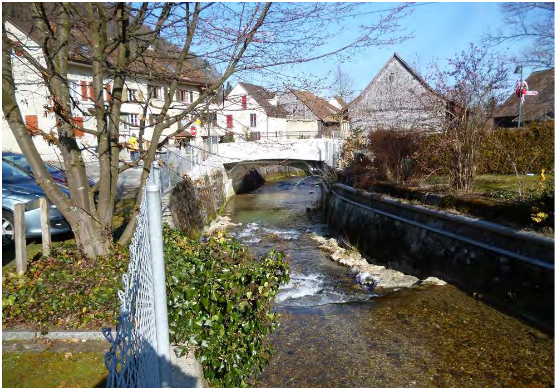
Oberdorf: Brücke Bennwilerstrasse, bachabwärts
