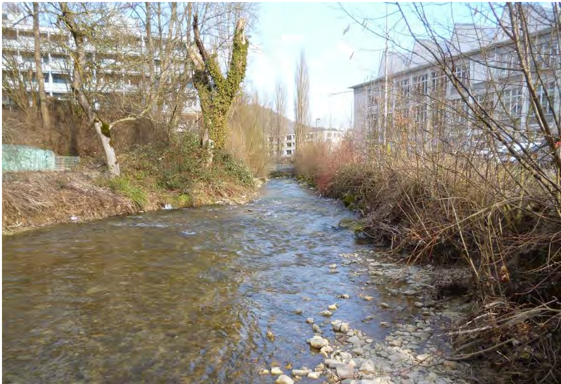
Liestal: Gerinneschwachstelle am Hanro-Gelände am rechten Ufer, Blick bachabwärts
