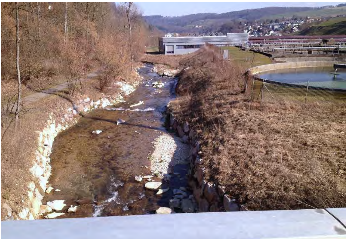
Niederdorf: Vordere Frenke, Höhe ARA, Blick bachabwärts
