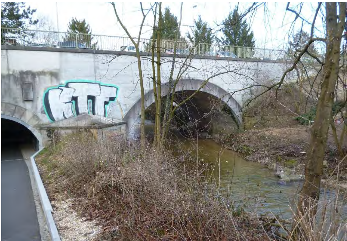
Liestal: Brücke Kasernenstrasse, Blick bachabwärts
