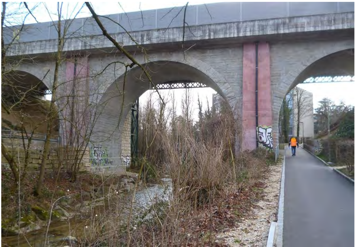
Liestal: Im Vordergrund die SBB- und dahinter die WB-Brücke (Eisenträgerbrücke) über die Vordere Frenke, Blick bachaufwärts
