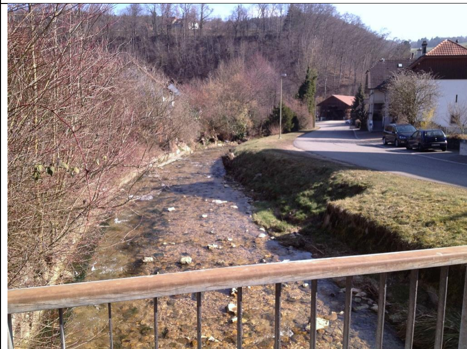
Gerinneabschnitt unterhalb Brücke Tiefenmattstrasse (Blick bachabwärts)
