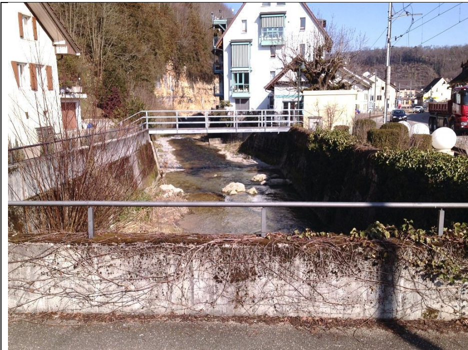
Fussgängersteg Hauptstrasse 26 von der Gwaagenbrücke aus gesehen (Blick in Fliessrichtung)
