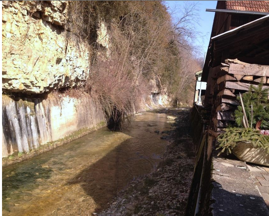
Gerinneabschnitt hinter den Häusern Haupt- strasse 22a-18. (Blick in Fliessrichtung)
