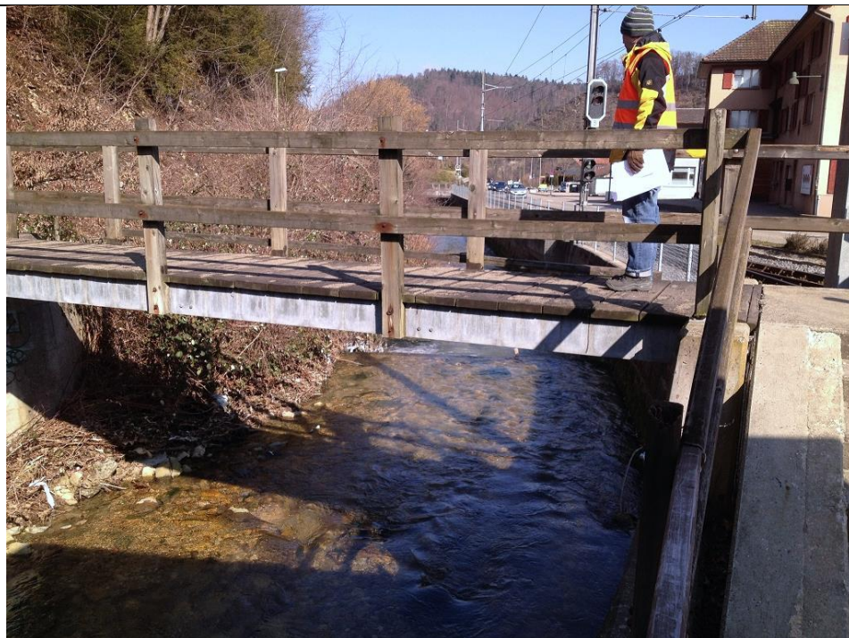
Fussgängersteg Hoh- lensträssli unterhalb der WB-Haltestelle (Blick in Fliessrichtung)
