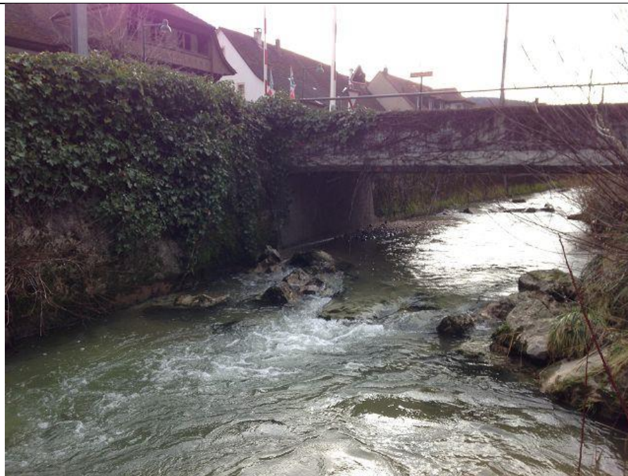
Unterwasserseite der Gwaagenbrücke (Blick bachaufwärts)
