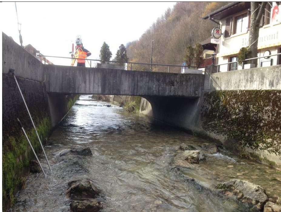
Unterwasserseite der Lindenbrücke (Blick gegen die Fliess- richtung)
