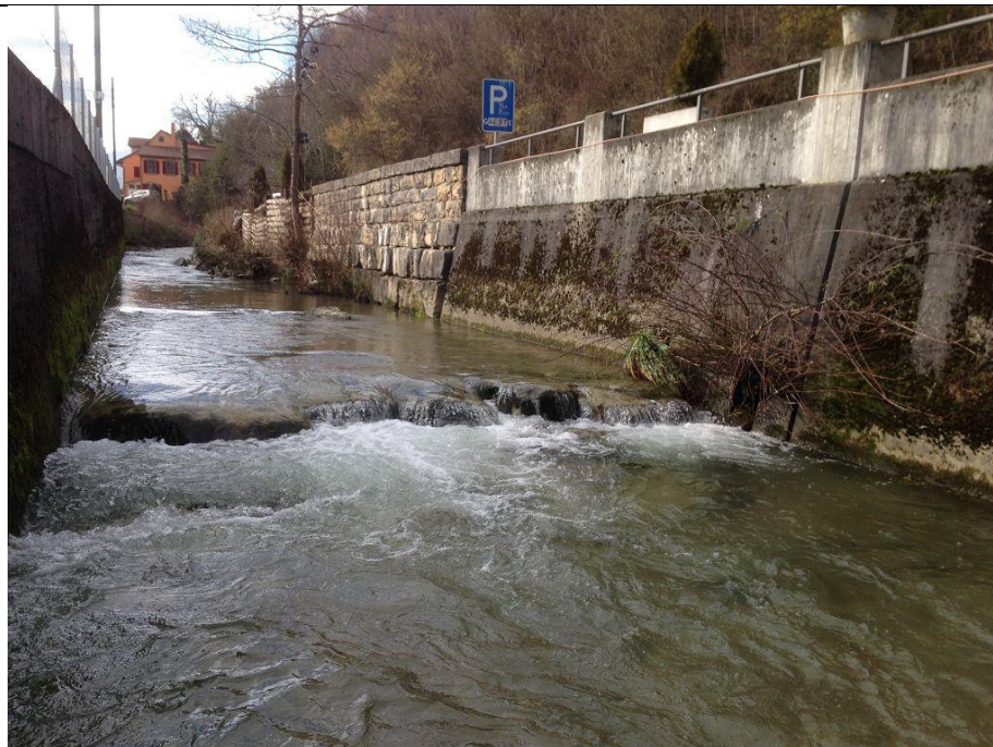
Gerinneabschnitt in Höhe Parkplatz des Restaurant Linde (Blick gegen die Fließrichtung)
