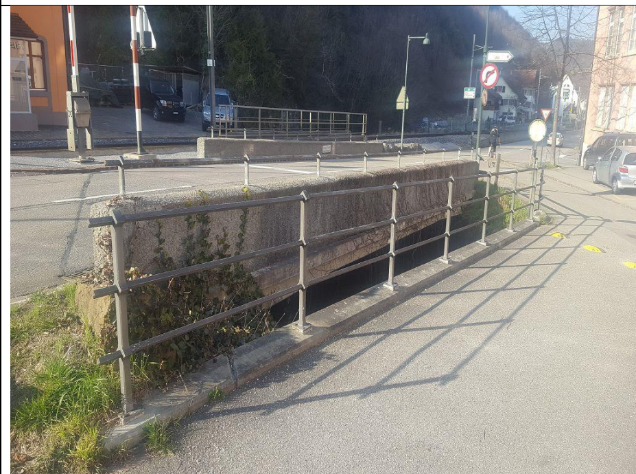
Die Frenke unterquert die Brücke Damm- strasse, die Postbrücke (Nr. 1.016, Kantons- strasse) und die WB- Brücke (Nr. 1.01) Blick in Fließrichtung
