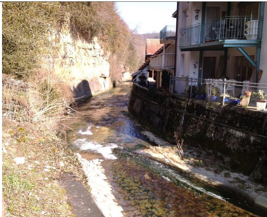
Gerinneabschnitt hinter den Häusern Haupt- strasse 24-20, im Vor- dergrund ist die ge- pflasterte Gewässer- sohle unterhalb Steg Hauptstr. 26 erkennbar (Blick in Fliessrichtung)
