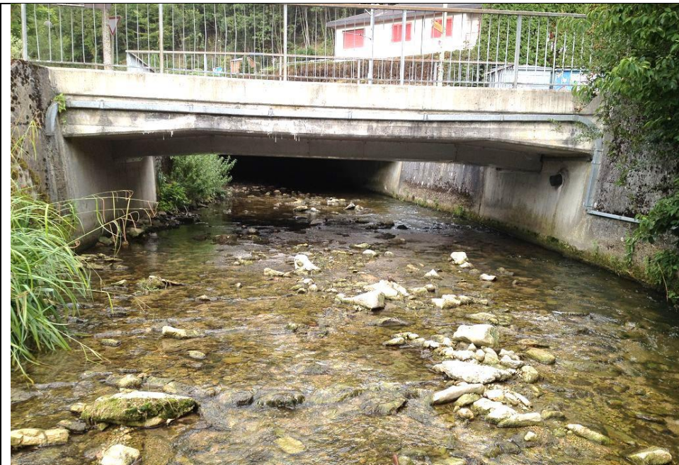
Brücke Tiefenmattstrasse unterhalb Durchlass Hölstein Nord (Blick gegen die Fliessrichtung)
