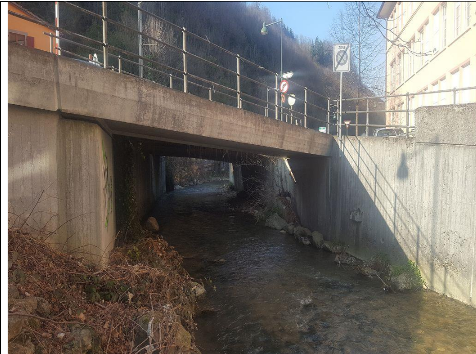
Einlauf Brücke Damm- strasse (Blick in Fließrichtung)
