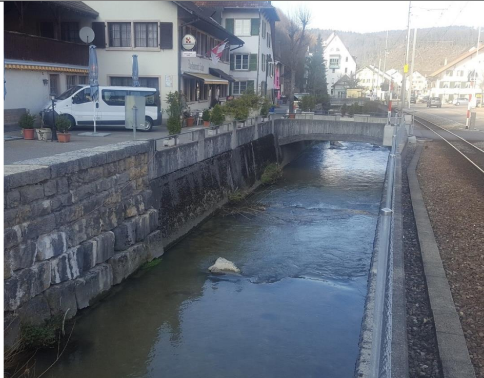
Lindenbrücke beim Restaurant Linde (Blick in Fliessrichtung)
